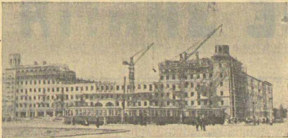
Полным ходом идет строительство последней секции 270-квартирного жилого дома на Предмостной площади. Это самый большой дом в нашем городе. Достаточно сказать, что его кубатура достигает 100 тысяч кубометров, жилая площадь — 10.400 квадратных метров. Квартиры в доме запроектированы в основном каждая из двух комнат.
