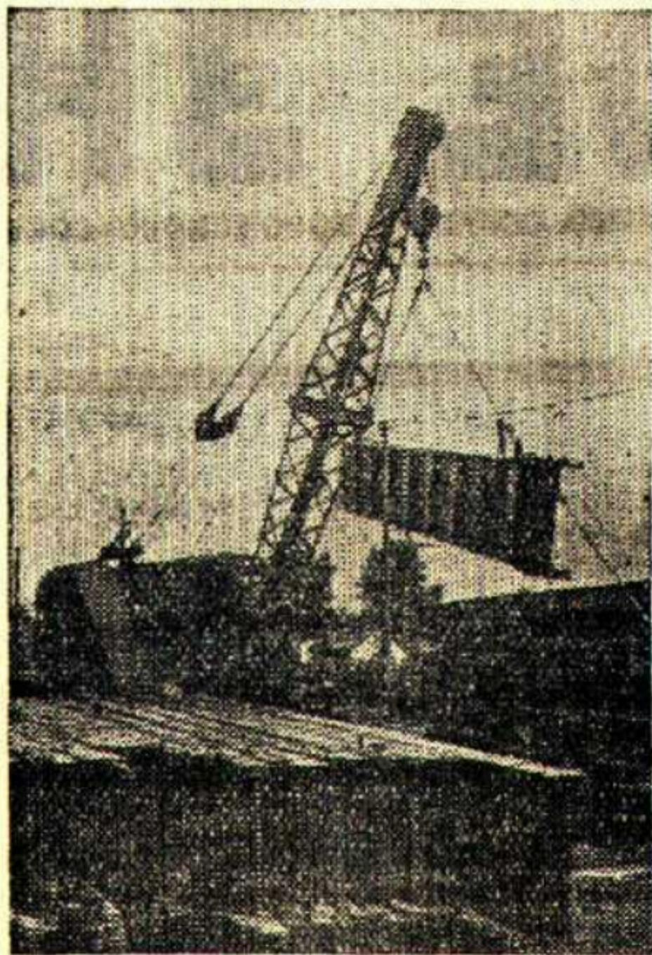
На строительстве коммунального моста через Абу закончено сооружение первых двух опор на кессонных основаниях. Мостовики приступили к монтажу пролетных строений.
