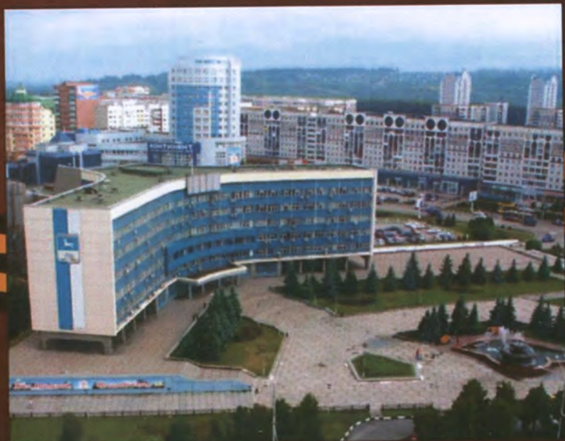
Здание администрации Новокузнецка
