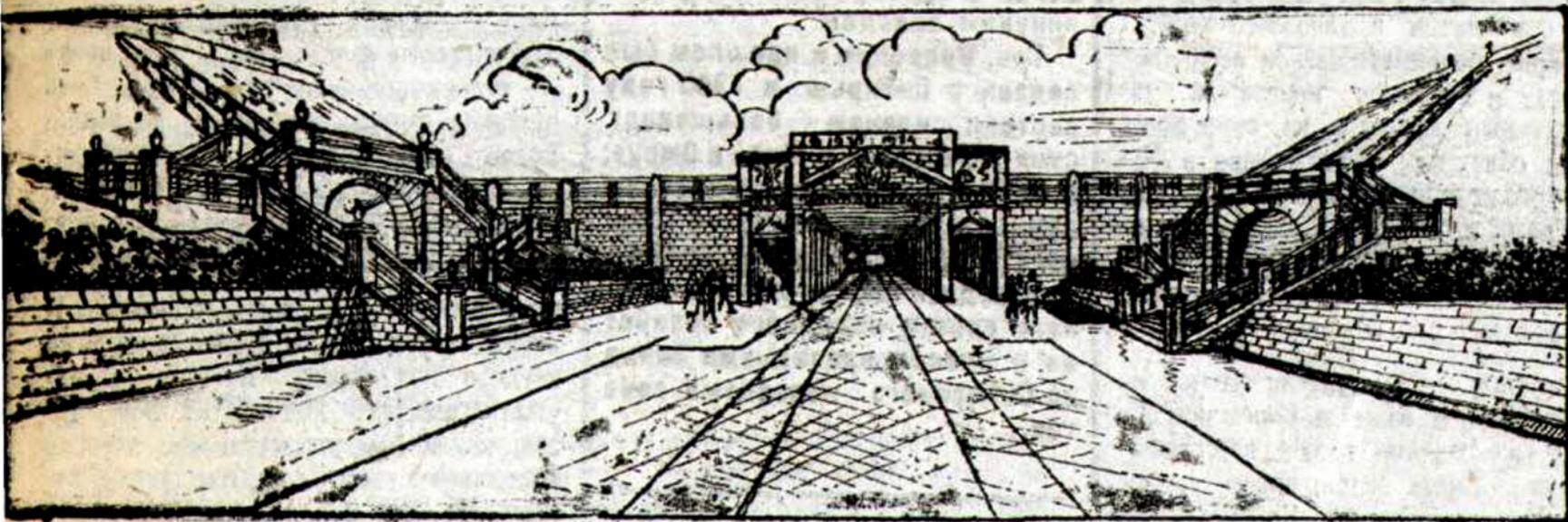
Земжеледорстрой приступил к подготовительным работам на верхнем выезде тоннеля. Мостовая будет сделана из торфа, специально заказанного в Ленинграде и уже высланного в Сталинск. Подпорные стены с двух сторон выезда будут облицованы камнем. Вдоль мостовой проведут тротуары и озеленят выход. Летом 1934 года работы будут закончены. На снимке: проект оформления верхнего выхода тоннеля
