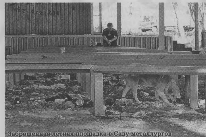
Заброшенная летняя площадка в Саду металлургов
