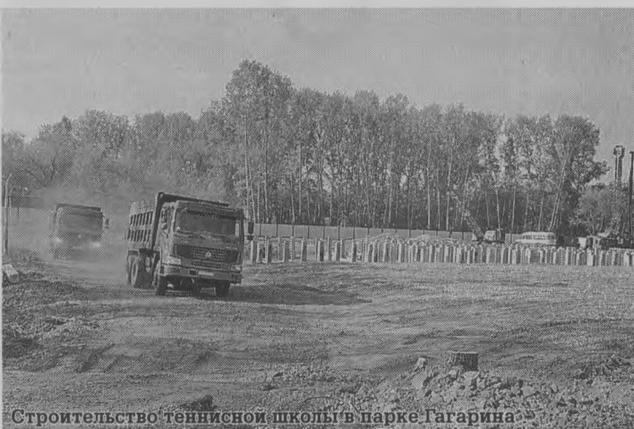
Строительство теннисной школы в парке Гагарина
