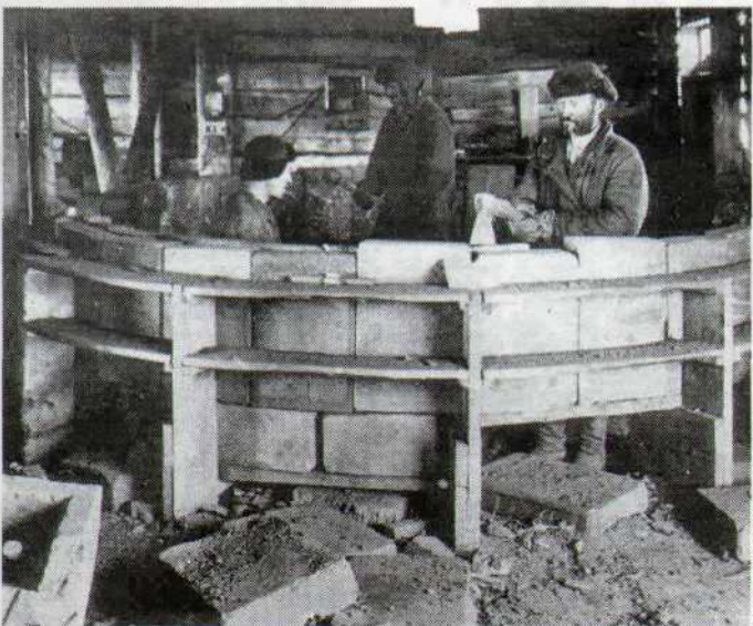
Вот так на электролизерах тех лет устанавливались бортовые блоки
