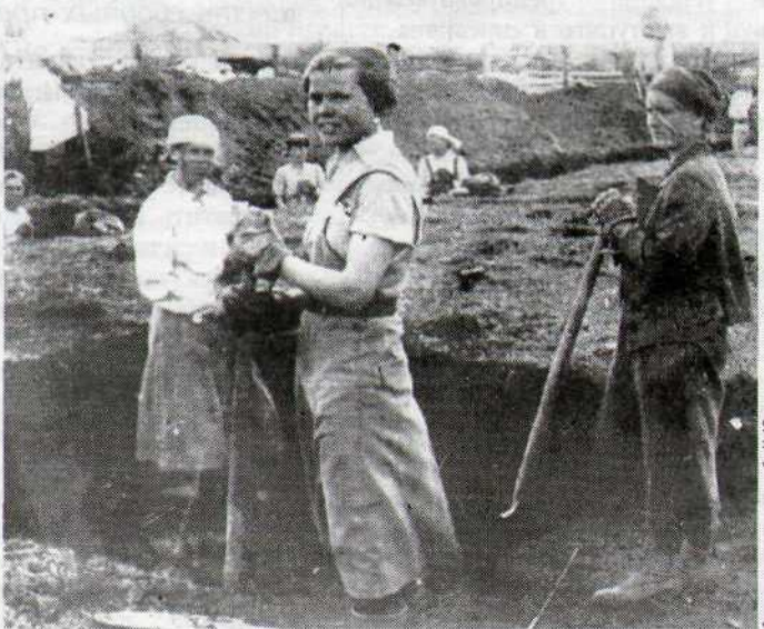
Большинство работ на стройке выполнялось вручную
